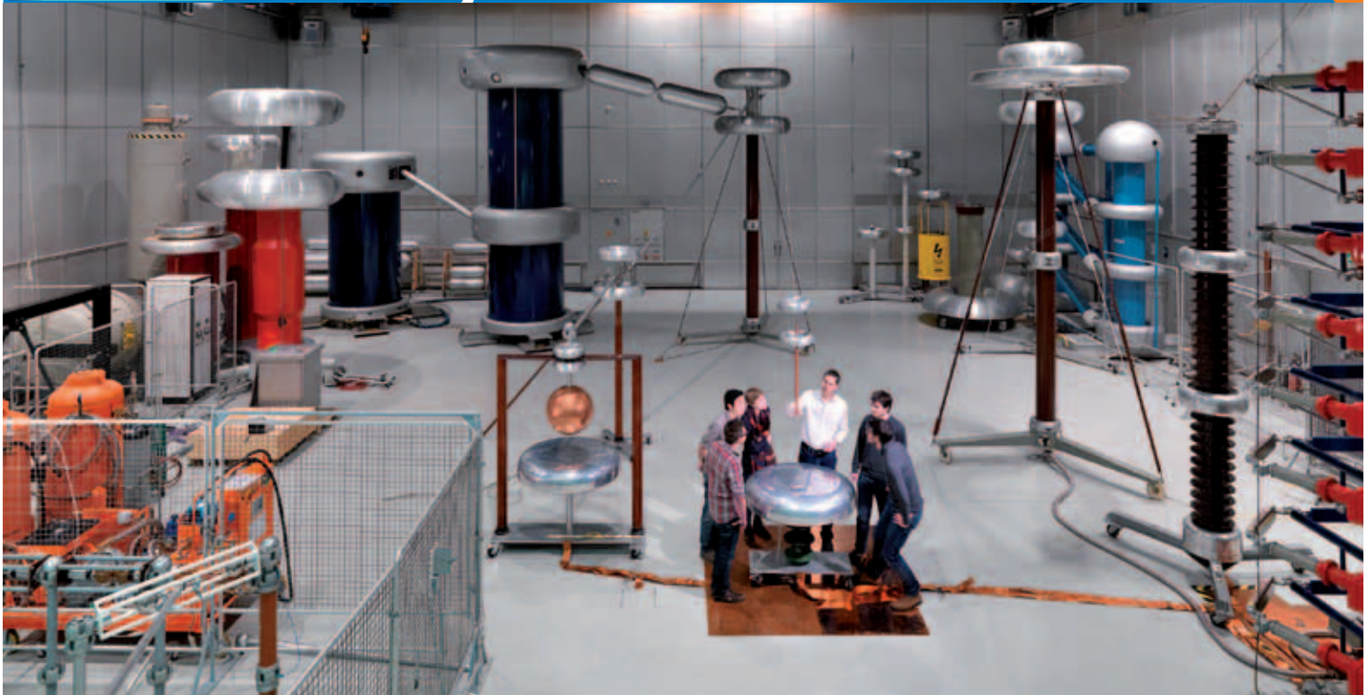
Blick in das Institut für elektrische Energieübertragung und Hochspannungstechnik: Im ETH-Energieleitbild haben Lehre und Forschung neben den eigenen Infrastrukturen einen zentralen Stellenwert. (Bild: Alexander Sauer/Scanderbeg Sauer Photography)
